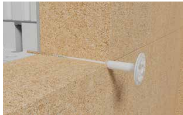
Der feste Dämmstoff wird nicht für die Geometrie des Dübels aufgeweitet, eine einfache Vormontage ist nicht möglich.
