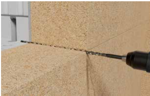
Bei der Verwendung von Standardbohrern in Holzfaserdämmstoffen können die Fasern häufig nicht abgeführt werden und verstopfen das Bohrloch.
